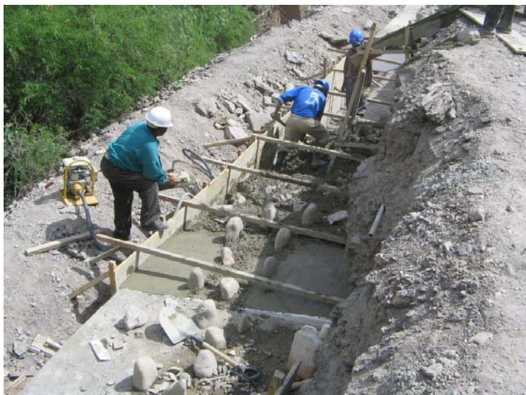
Figura 4.5.1.6: Concretagem de um lance da base entre outros dois
