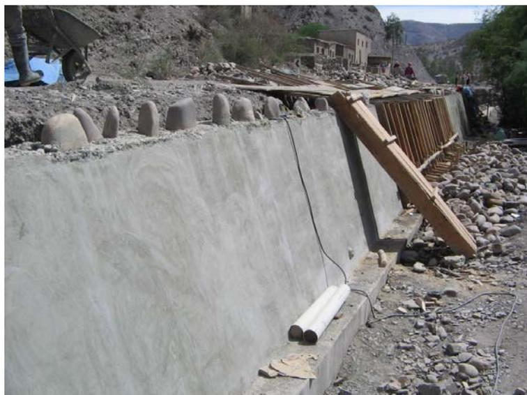
Figura 4.5.1.7: Engastamento de pedras de mão entre camadas de concretagem
