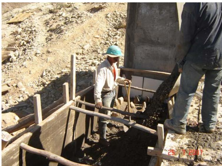
Figura 4.5.1.5: Preparação das formas e concretagem
