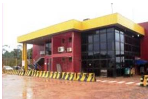
Figura 24. Prédio Administrativo do TUP Passarão em Porto Velho.
