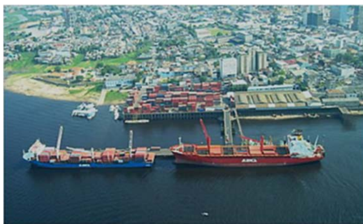
Figura 41. Cais das Torres – Porto Público de Manaus
