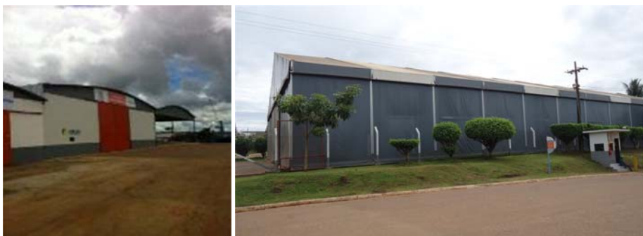
Figura 20. Imagens dos armazéns do Porto Organizado de Porto Velho
