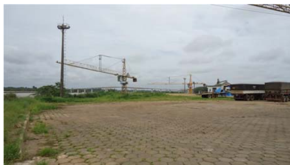
Figura 21. Imagem do pátio dos guindastes do Porto Organizado de Porto Velho
