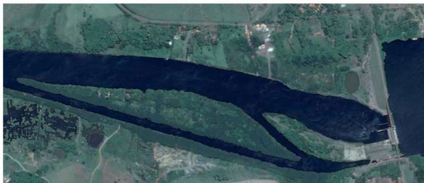
Figura 65. Imagem aérea da Eclusa de Bariri e do canal de navegação
