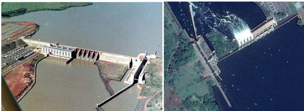
Figura 67. Imagens da Eclusa de Barra Bonita no Tietê
