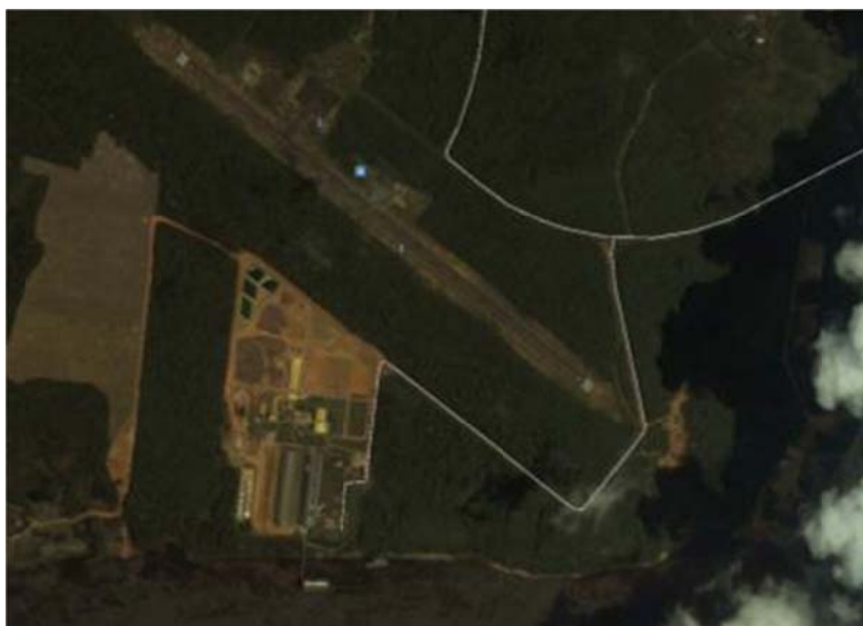
Figura 29. Vista aérea dos acessos rodoviários ao terminal de Itacoatiara
