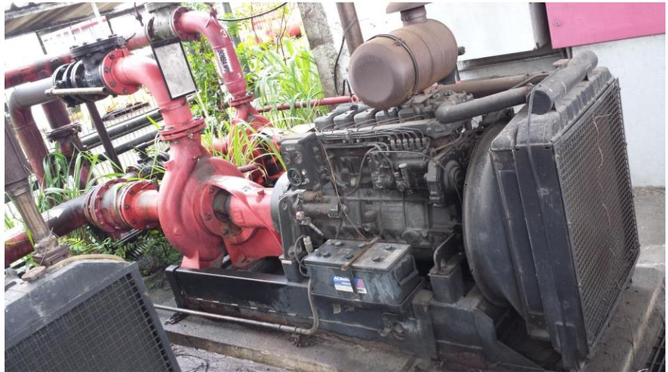
Figura 22 - Moto-bomba de incêndio no arrendamento STS13A
