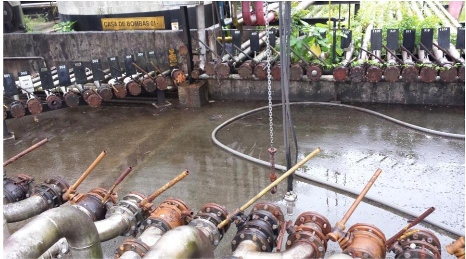
Figura 21 - Casa de Bombas de exportação com a conexão de cada tanque individualmente
