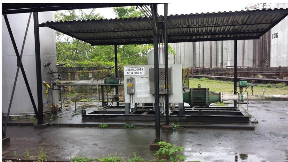
Figura 25 - Sistema de Oxidação Térmica de Vapores existente no arrendamento STS13A
