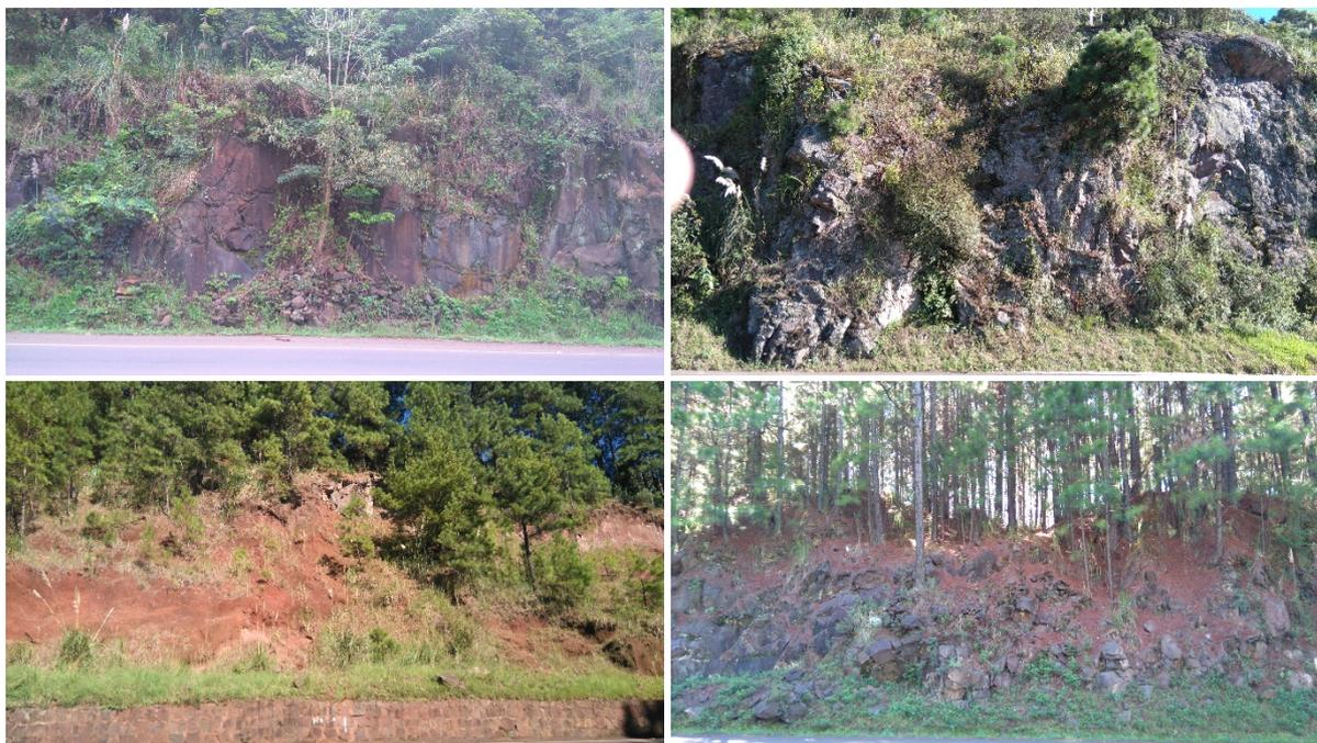
Figura 48 – Fotografias mostrando afloramento do tipo corte de estrada contendo diversas feições relacionadas a movimentos de massa terrosos e rochosos em conjunto ao longo da Área em Estudo.
