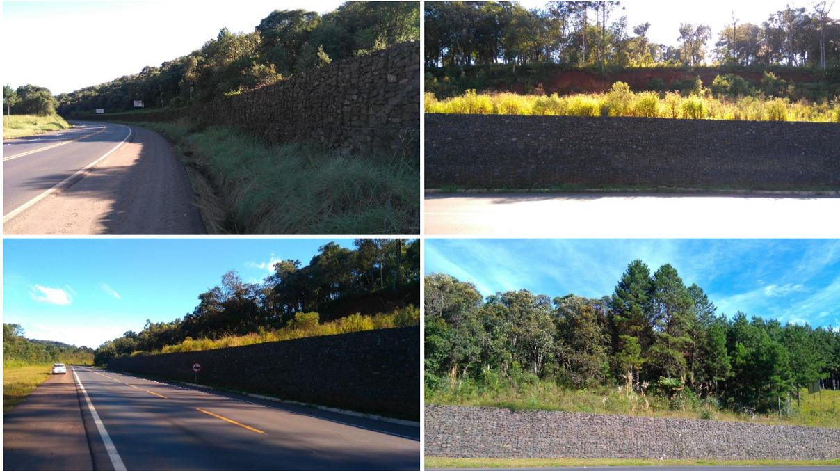
Figura 50 – Fotografias mostrando muros de arrimo construídos para conter problemas relacionados a movimentos de massa e instabilidade de taludes ao longo da Área em Estudo.
