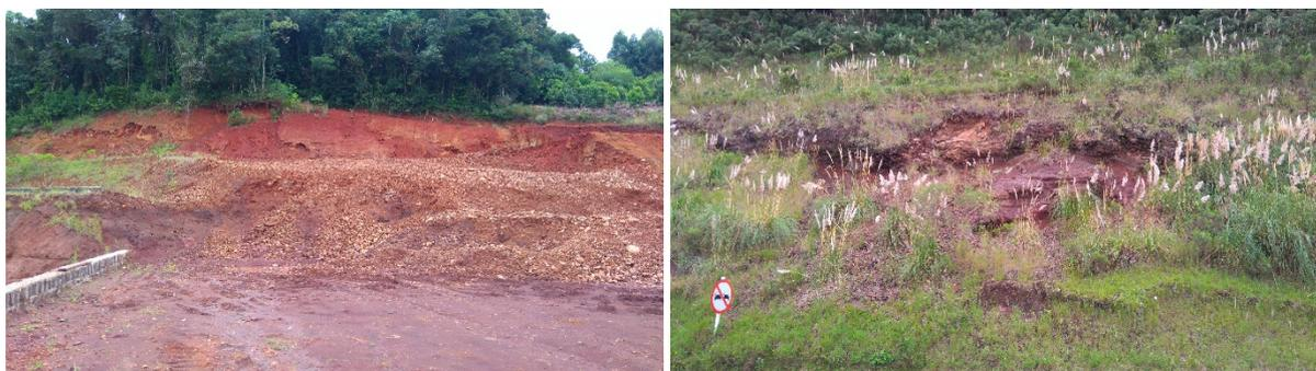
Figura 47 – Fotografias mostrando afloramento do tipo corte de estrada contendo diversas feições relacionadas a instabilidade de taludes ao longo da Área em Estudo.
