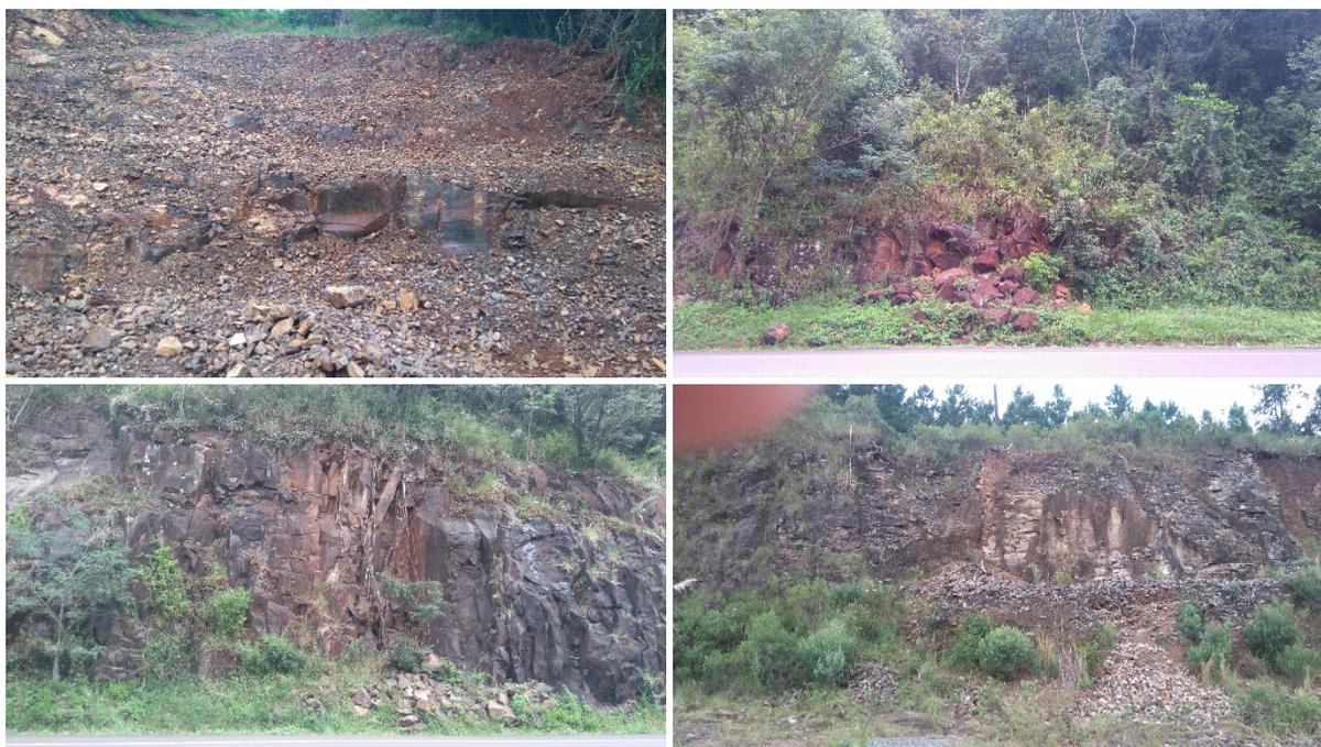
Figura 46– Fotografias mostrando afloramento do tipo corte de estrada contendo diversas feições relacionadas a movimentos de massa rochosos ao longo da Área em Estudo.
