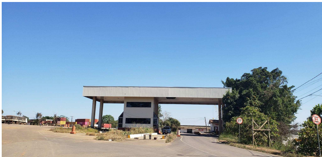
Figura 69. Nova portaria de acesso do porto, ainda não está em funcionamento.
