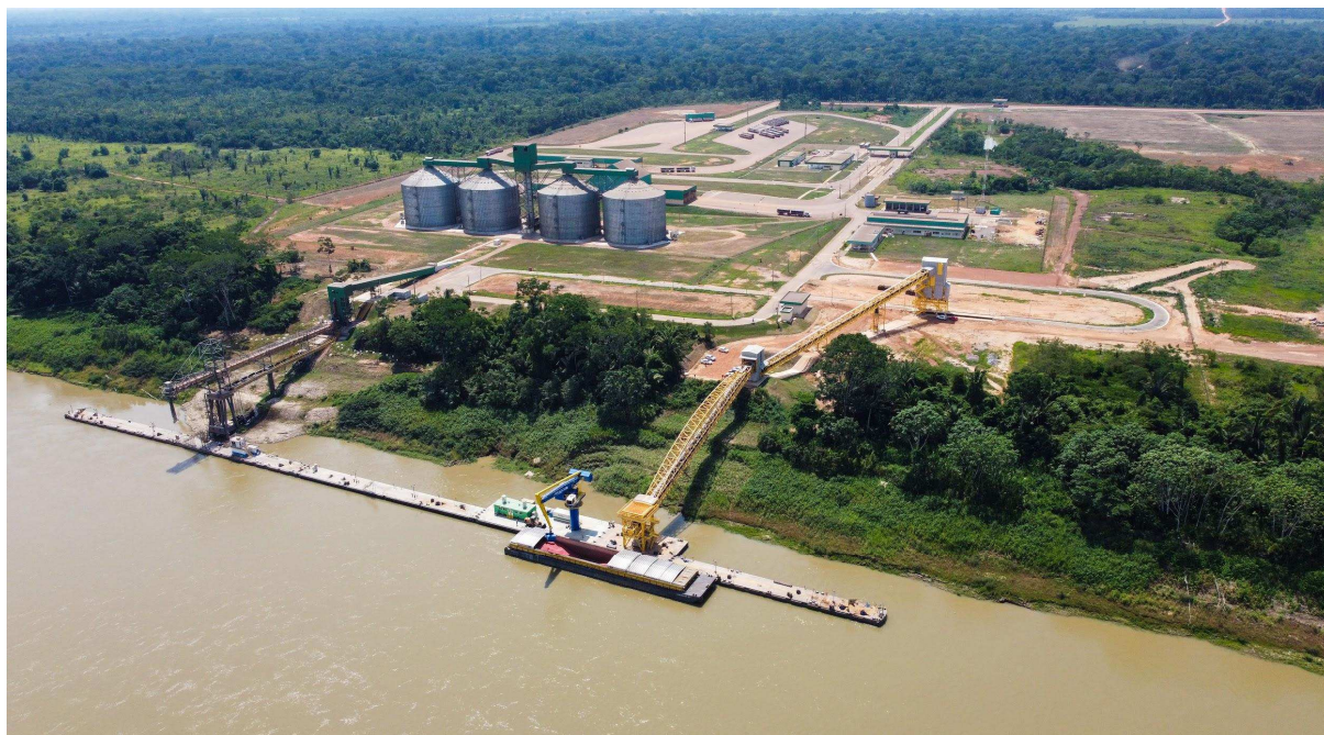
Figura 46. Perspectiva ampla do Terminal de Expedição do Portochouelo ilustrando os processos de recepção rodoviária (parte superior), armazenamento (parte central) e sítio de embarque de grãos vegetais e aparato logístico de recepção do fertilizante para desembarque aquaviário (parte inferior, vide ligação do píer flutuante - ocupado com a barcaça - com sistema das esteiras, denotadas e sustentadas por treliças amarelas) e posterior embarque rodoviário.
