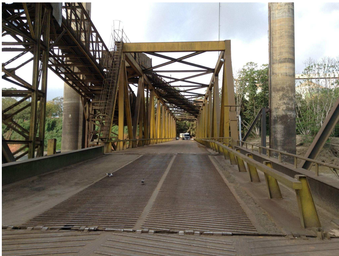
Figura 17. Sistema de Esteiras acima do Pórtico e ao lado da ponte de Acesso ao Cais Flutuante.
