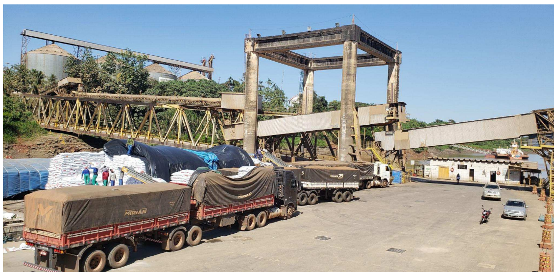
Figura 18. Visão ampla do traçado realizado pelo Sistema de Esteiras desde os Silos, passando pelo pórtico, até shiploader no Cais Flutuante.
