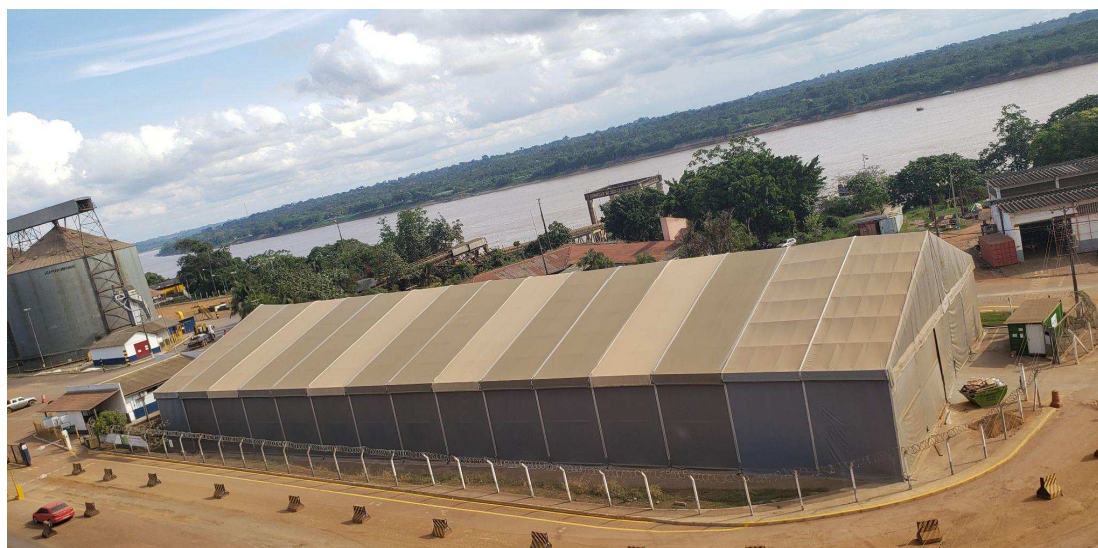
Figura 12. Pátio 3 do Porto de Porto Velho, ocupado pelo armazém lonado.
