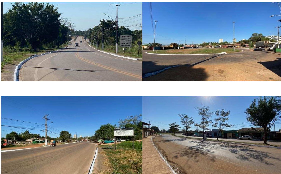
Figura 94. Vistas da BR-319 junto à entrada do Porto Organizado de Porto Velho.
