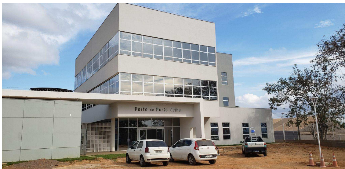
Figura 19. Nova Sede Administrativa da SOPH (ainda não finalizada). Fonte: Imagens obtidas durante a visita técnica. Elaboração: EPL (2021).
