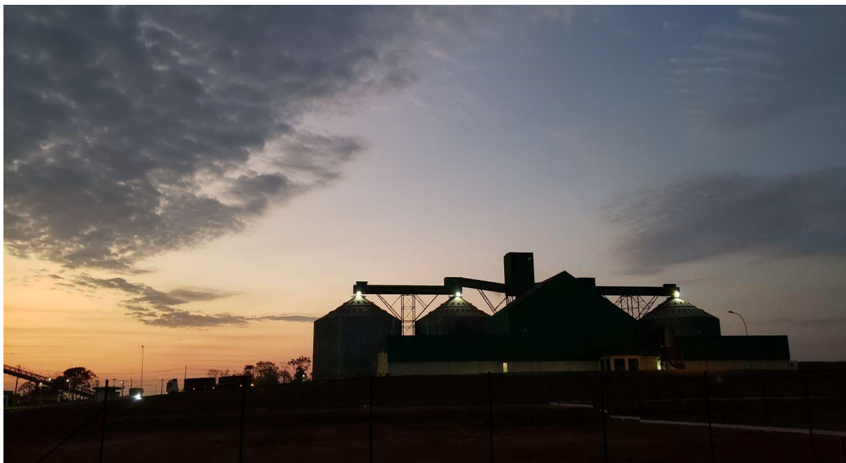
Figura 43. Arranjo dos silos no Terminal. Fonte: Imagem obtida durante a realização das visitas técnicas.
