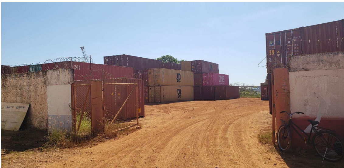
Figura 9. Pátio de Contêineres do Porto de Porto Velho Fonte: Imagem obtida durante a visita técnica. Elaboração: EPL (2021).
