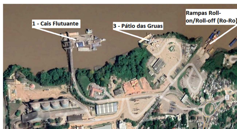
Figura 2. Localização das estruturas de acostagem do Porto de Porto Velho. (1) Cais Flutuante, (2)
