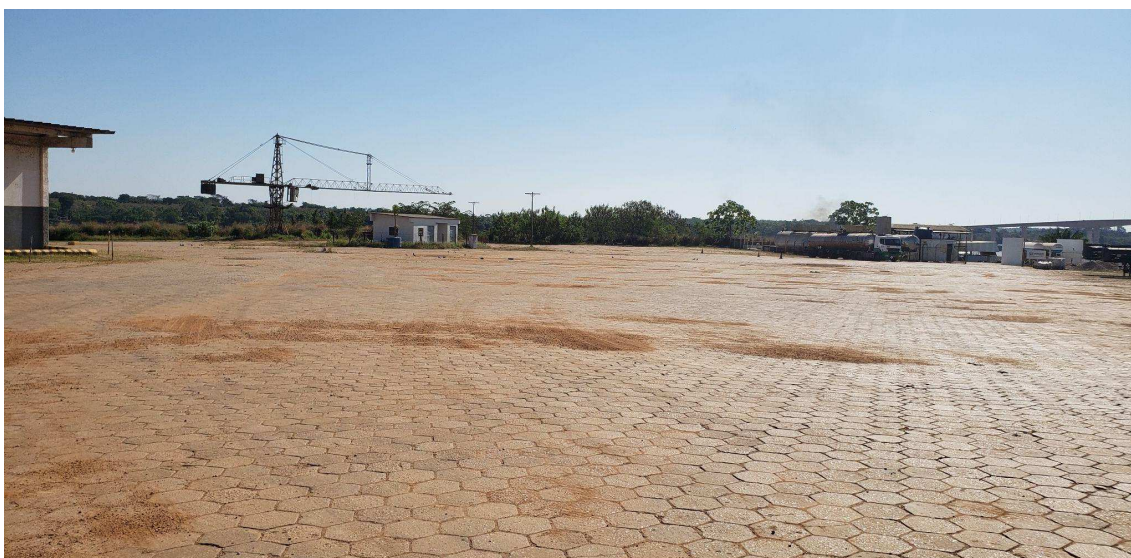
Figura 8. Pátio das Gruas do Porto de Porto Velho. Fonte: Imagem obtida durante a visita técnica (2021). Elaboração: EPL (2021).
