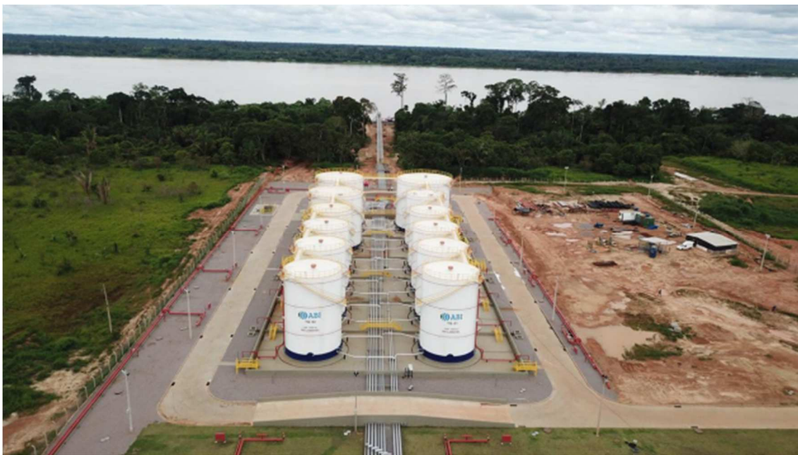
Figura 29. Tanques e área de Expansão futura (à direita da Fotografia). Rio Madeira (em segundo plano). Fonte: ABI. Elaboração: EPL (2021).
