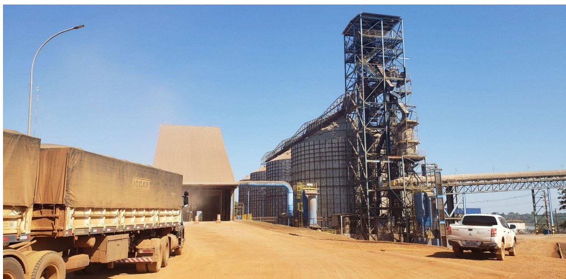
Figura 26. Posicionamento dos silos na interface entre o modal rodoviário (à esquerda na foto o caminhão se direcionando ao tombador de grão) e o aquaviário (sistema de esteiras direcionadas ao píer flutuante).
