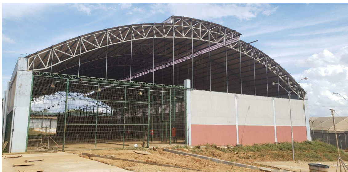
Figura 21. Armazém Alfandegado de Cargas Gerais (ainda não finalizado). Fonte: Imagens obtidas durante a visita técnica. Elaboração: EPL (2021).
