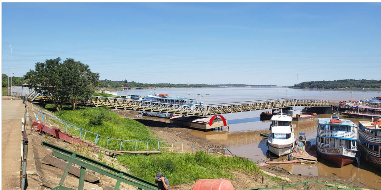
Figura 47. Ponte de acesso ao IP4 Cai N'água (em segundo plano, encontra-se a barragem de Santo Antônio à montante da Instalação Portuária).
