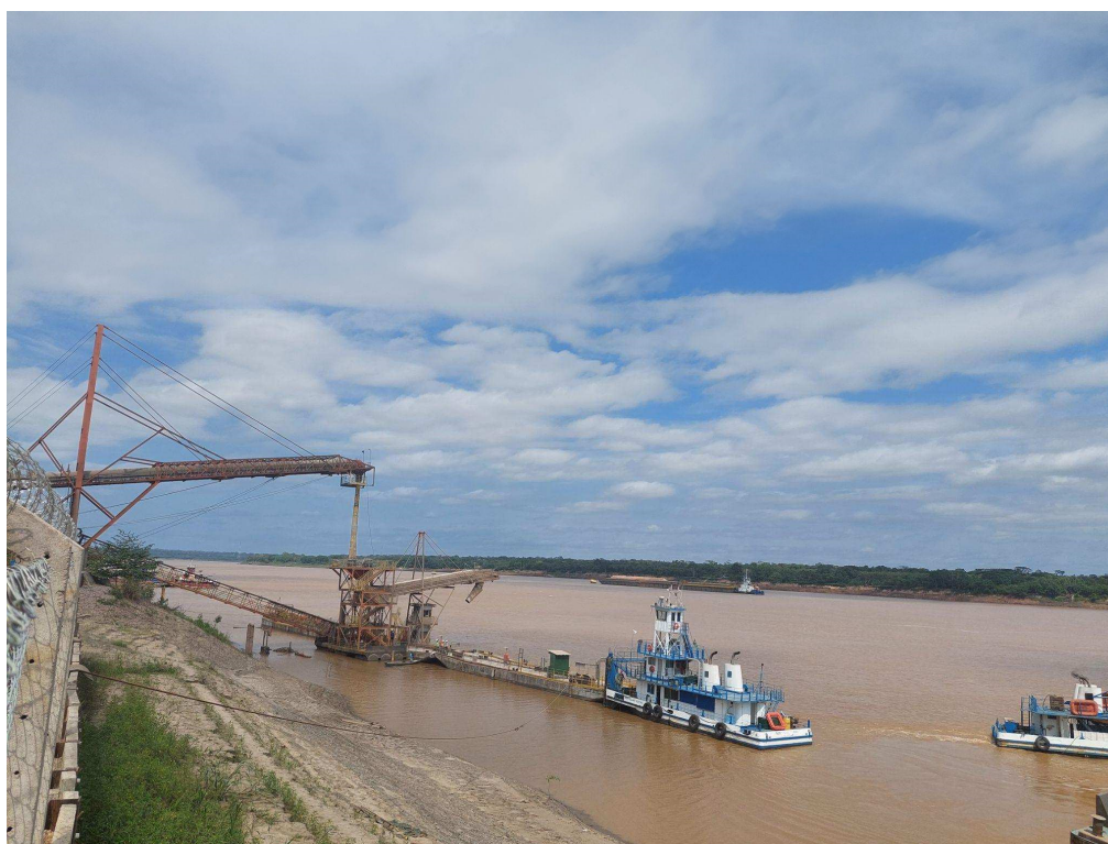
Figura 38. Píer flutuante do TUP Cargill Agrícola e posicionamento do shiploader .
