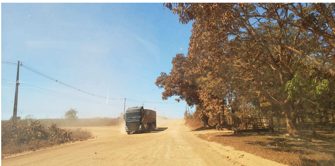
Figura 72. Ausência de pavimentação em parte do Ramal 28 de Novembro.
