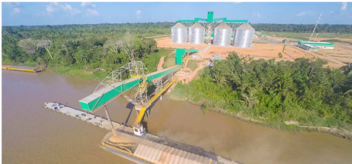
Figura 42. Pier flutuante e respectiva ligação do shiploader e sistema de esteiras oriundas dos silos. Fonte: Amaggi. Elaboração: EPL (2021).
